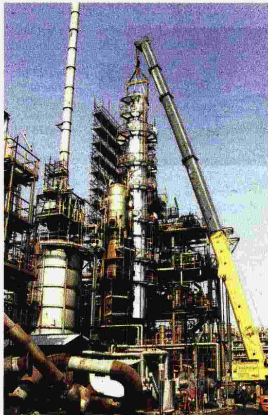
LAVORI CONCLUSI La posa del gigante alto 34 metri
